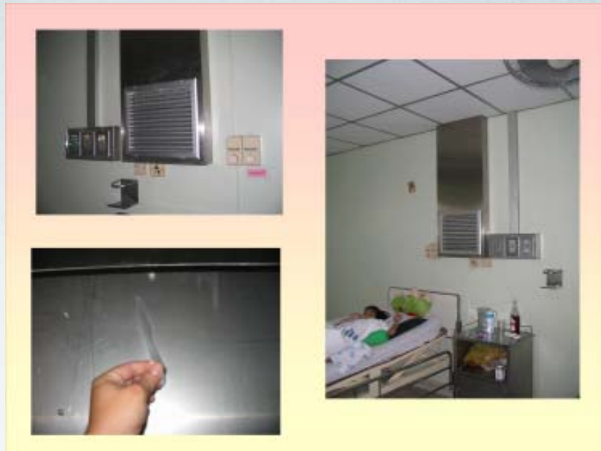
ภาพที่ 17 แสดงหน้าการระบายลมที่หัวเตียงผู้ป่วย หัวจ่ายออกซิเจน และที่ดูดเสมหะ ในห้องแยกผู้ป่วยแบบประยุกต์ (Modified AIRR)
