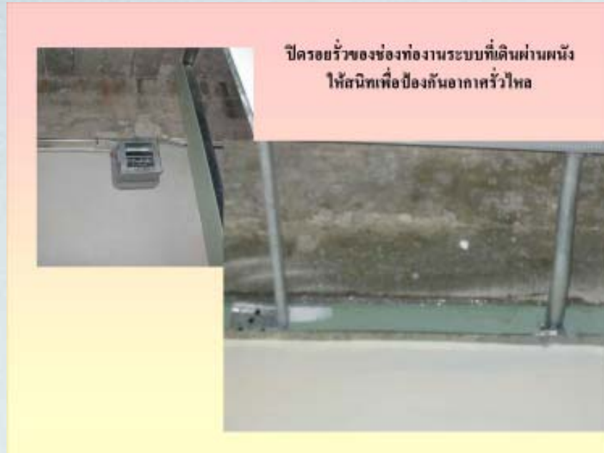
ภาพที่ 5 แสดงการก่อสร้างเพื่อจำกัดรูรั่วของห้อง AIIR
