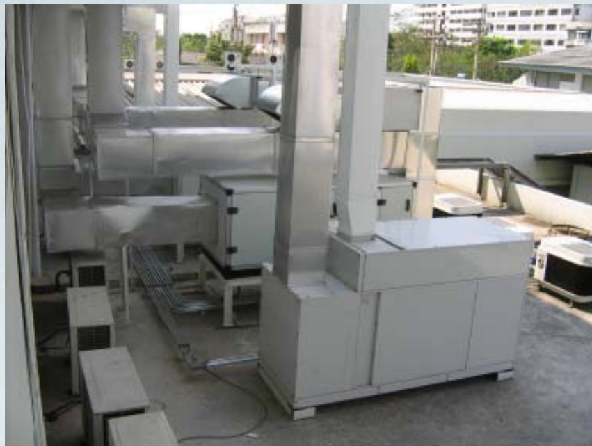
ภาพที่ 29 แสดงเครื่องปรับอากาศ /กล่องอุปกรณ์การกรองและระบายอากาศ จากห้องตรวจส่องกล้อง
