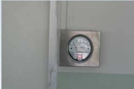
ภาพที่ 27 แผงวัดความดันอากาศของห้องตรวจสอบกล้อง
