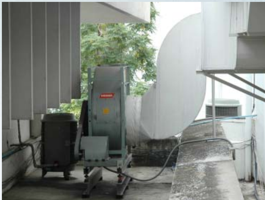
ภาพที่ 39 พัดลมดูดอากาศ จากบริเวณโรงรถตรวจผู้ป่วยนอกอายุรกรรม
