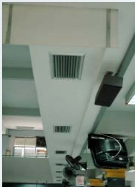
ภาพที่ 38 แสดงแผงดูดลมทิ้งของระบบระบายอากาศ ที่บริเวณโรงรถตรวจผู้ป่วยนอก อายุรกรรม
