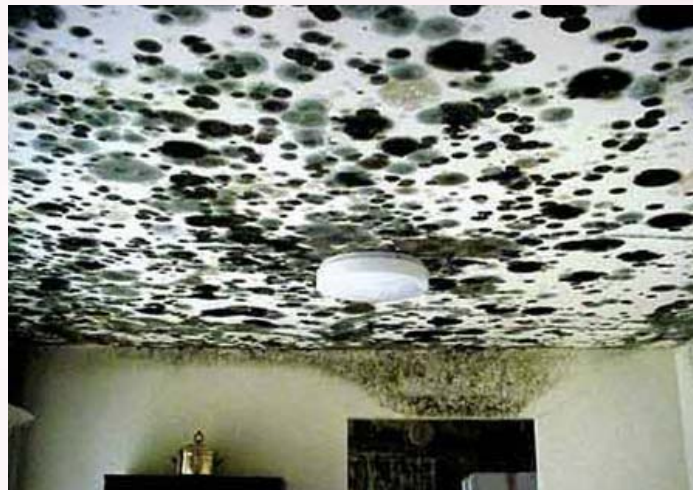
รูปที่ 7 บริเวณที่มีความชื้นสูงและแสงแดดส่องไม่ถึง เชื้อราจะเจริญเติบโตได้อย่างรวดเร็ว
