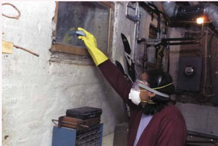
รูปที่ 8 การทำความสะอาดเชื้อรา โดยสวมแว่นตา, ถุงมือ และหน้ากาก N-95
