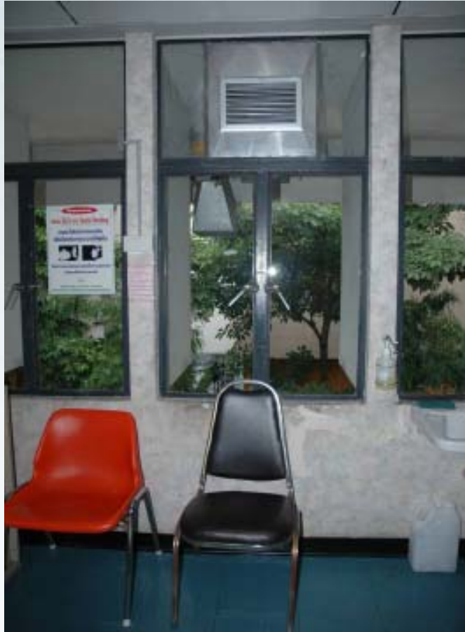
ภาพที่ 37 แสดงระบบระบายอากาศภายในห้องพ่นยา
