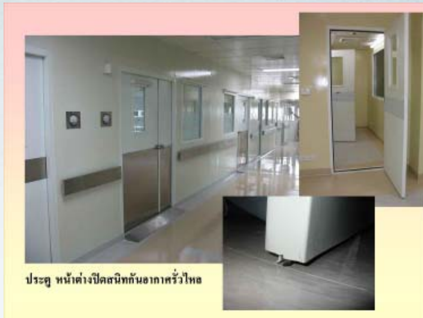
ภาพที่ 6 แสดงการปิดรูรั่วของขอบประตู หน้าต่าง เพื่อกันการรั่วไหลของอากาศ
