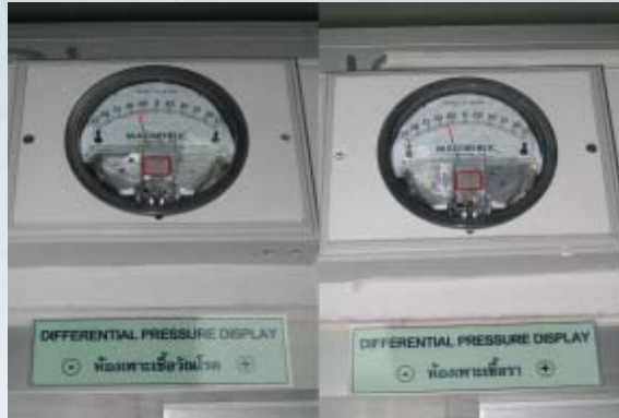
ภาพที่ 31 แผงวัดความดันอากาศในห้องเพาะเชื้อวัณโรค และห้องเพาะเชื้อรา
