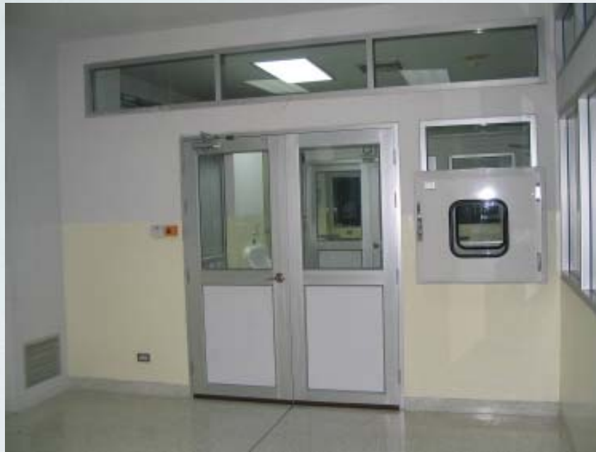
ภาพที่ 30 ห้องปฏิบัติการเพาะเชื้อวัณโรค เชื้อรา และเชื้อโรคอันตราย สถาบันบำราศนราดูร
